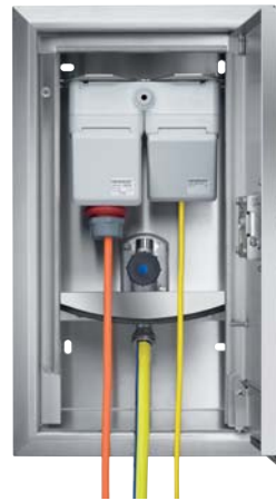
KEMPER 'Tresor' wandinbouwkast figuur 210, H/B/D: 470x250x120 mm
